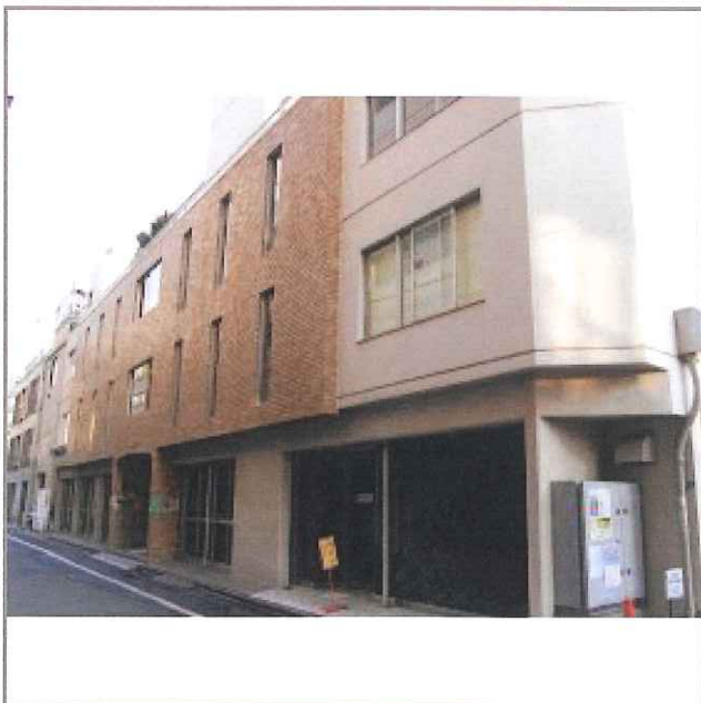
谷田部ビル 外観
