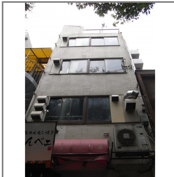
三新ビル2・3・4階外観
