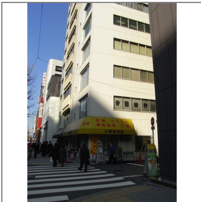
小森ビル外観
